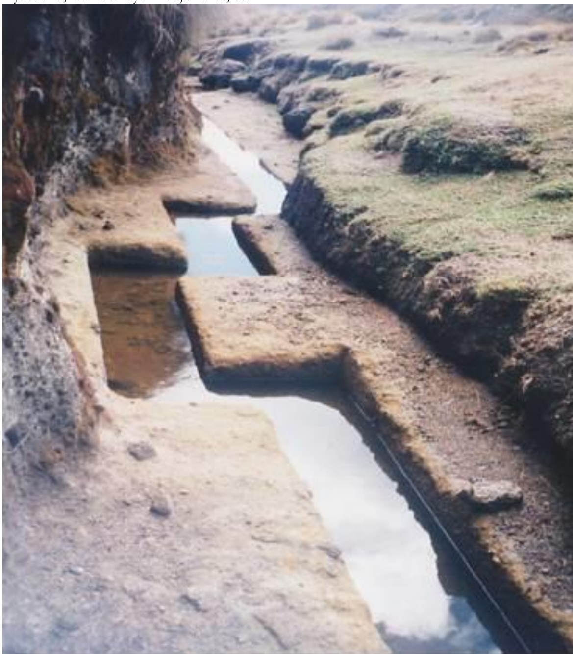
Fotografía 31. Canal pétreo construido para la reducción del flujo hídrico. Cumbemayo - Cajamarca
